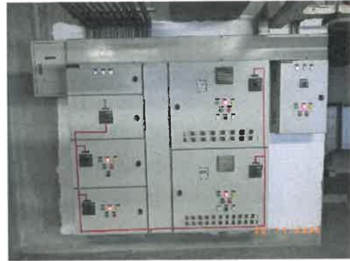
รูปที่ 2- 35 อุปกรณ์ควบคุมความเร็วรอบของระบบพัดลม
