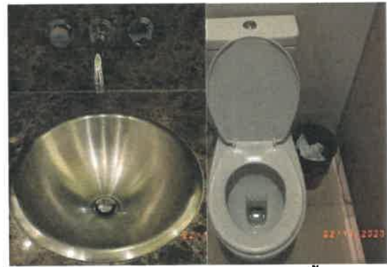
รูปที่ 2- 20 สุขภัณฑ์แบบประหยัดน้ำ
